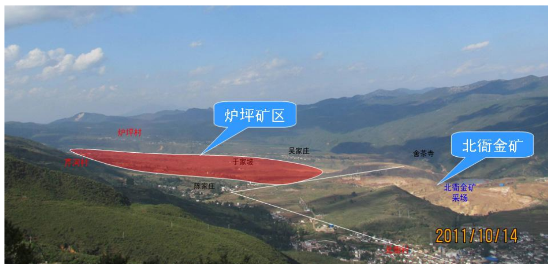
图 1-1 炉坪铅多金属矿区全景
