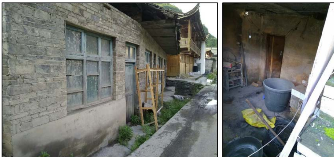
图 3-1 位于司前大坝居民家中地下室的土法炼汞场所
