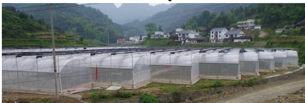
图 5.12 示范项目建设地点：下溪乡抱溪村 坤鑫农业蔬菜大棚
