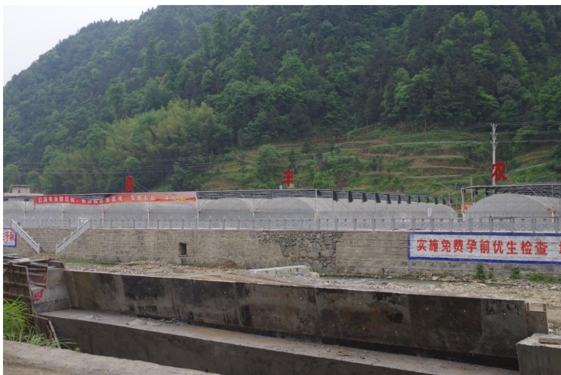
图 5.14 示范项目建设地点：下溪乡兴隆村 鑫丰农业蔬菜大棚
